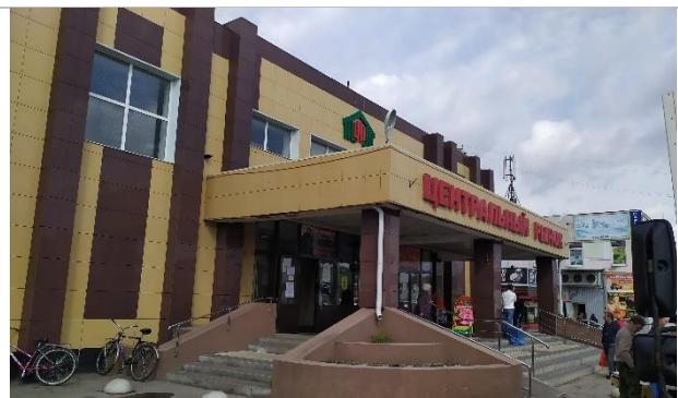
Фотография 17. Прилегающая территория
