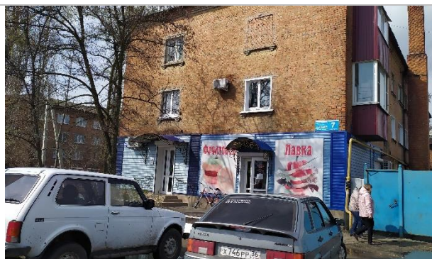
Фотография 16. Прилегающая территория
