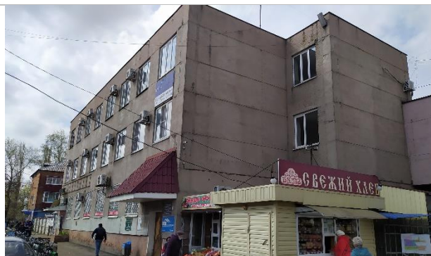
Фотография 13. Фасад здания
