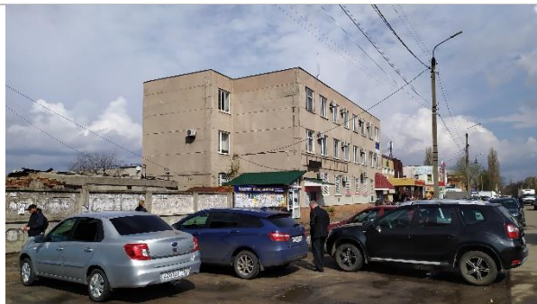
Фотография 3.2. Внешнее состояние объекта оценки
