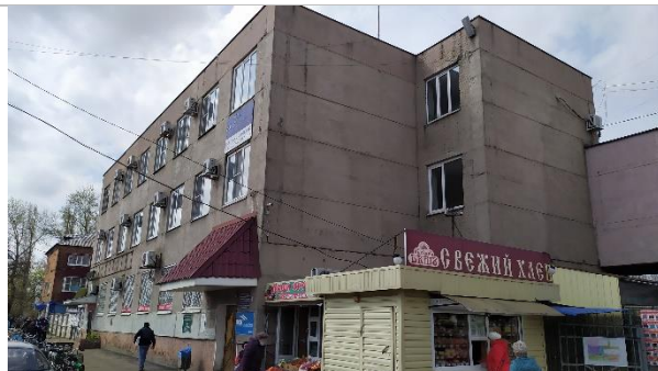
Фотография 3.1. Внешнее состояние объекта оценки
